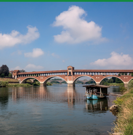
IL PONTE COPERTO SUL FIUME TICINO
