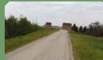
Realizzazione di un tratto della "Ciclovía del Po" attraverso i territori di Arena Po, San Cipriano Po, Albaredo Arnaboldi e Mezzanino.
