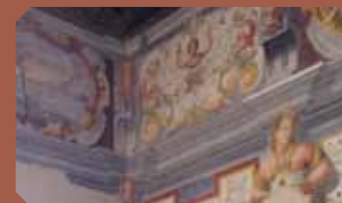
Realizzazione di interventi di riqualificazione di due importanti parti del castello.
