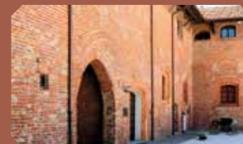
Messa in sicurezza del muro di cinta, dei serramenti esterni e della copertura del Castello Visconteo.
