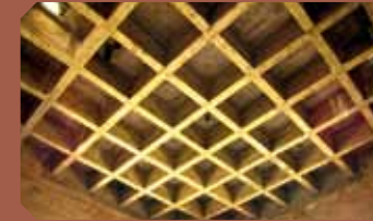
Restauro del Castello Visconteo con il recupero di spazi per incrementare i servizi culturali offerti ai cittadini e ai turisti.
